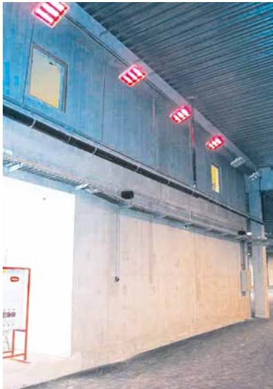
IRCF kan monteras på vägg eller i tak, och är lämplig i byggnader som inte används regelbundet, t.ex startzonen på den här gocart-banan.
