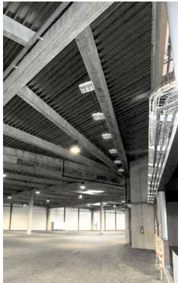
IRCF kan monteras på vägg eller i tak, och är lämplig i byggnader som inte används regelbundet, t.ex startzonen på den här gocart-banan.
