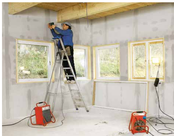
Nagrzewnice Tiger 3-9 kW (400V3N~) mają z tyłu gniazdo 230 V, do którego można bez trudu podłączyć np. oświetlenie lub ładowarkę do narzędzi bezprzewodowych. To praktyczne rozwiązanie na budowach!
