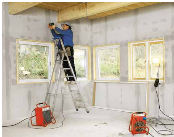
Le Tiger 3-9 kW (400V3N~) dispose d'une sortie de 230 V à l'arrière, pour un branchement aisé par exemple d'un dispositif d'éclairage ou d'un chargeur pour les outils sans fil. Pratique pour les chantiers !
