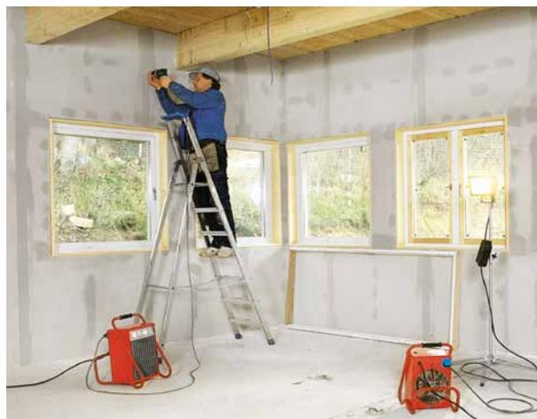
Los modelos Tiger de 3 a 9 kW (400V3N~) tienen una toma de 230 V en la parte trasera que permite conectar, por ejemplo, una lámpara portátil o el cargador de una herramienta sin cable. ¡Muy práctico en obras!
