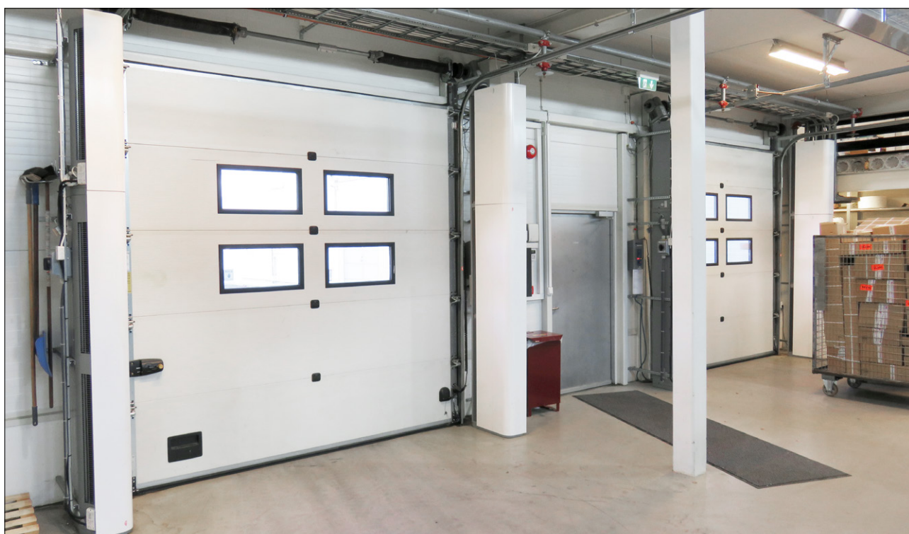
При установке двух завес Pamir 5000 в колонну применяется соединительные комплекты для крепления к полу и между собой.
