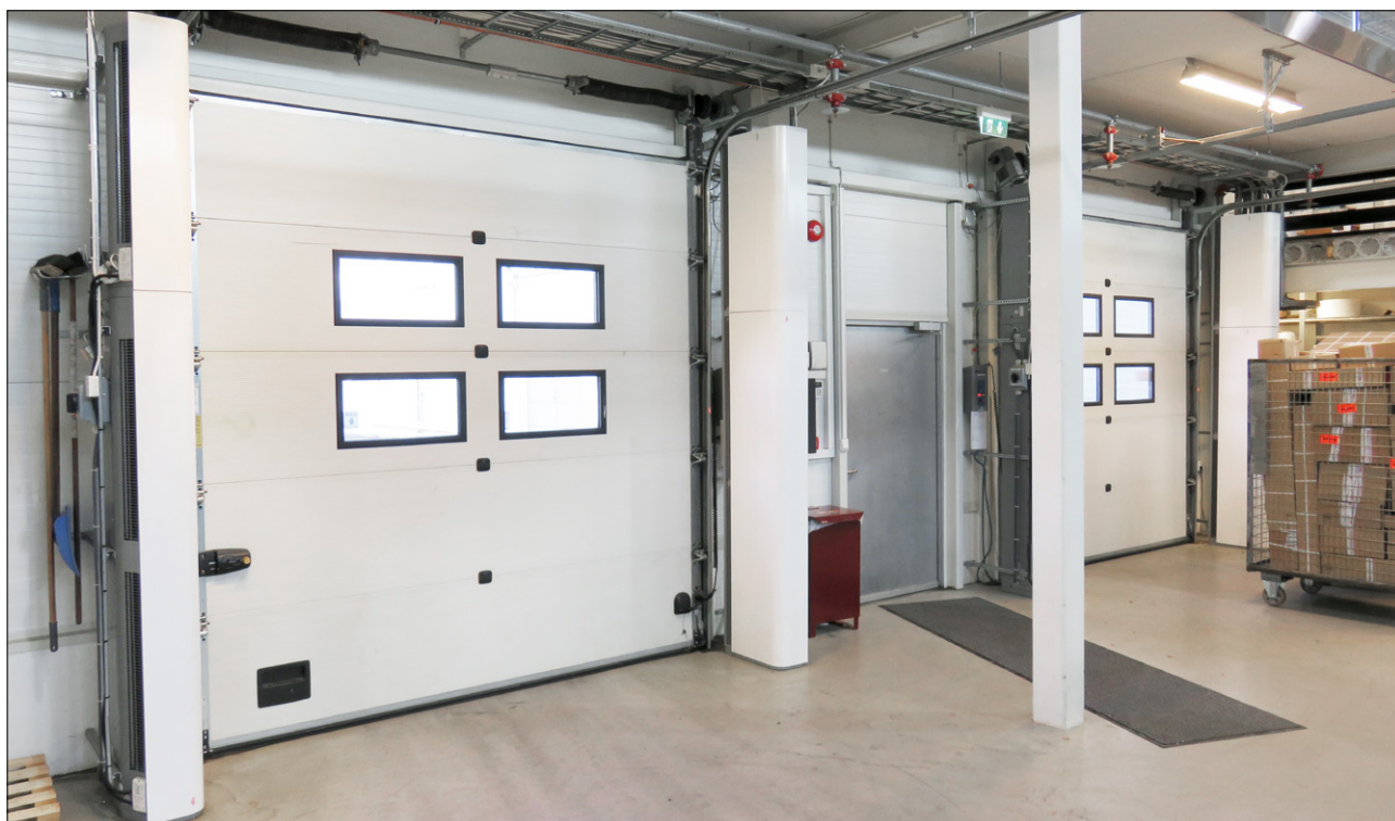
Zamontowane pionowo urządzenie Pamir 5000 z zestawem do montażu pionowego, który umożliwia montaż dwóch urządzeń jedno na drugim.
