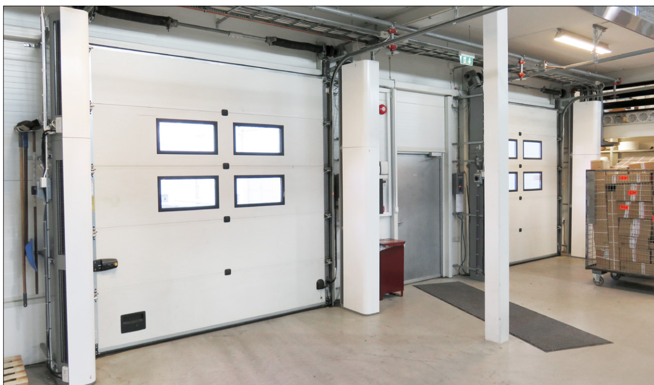
Pamir 5000 installata verticalmente con un kit verticale per consentire l'installazione di due unità una sull'altra.
