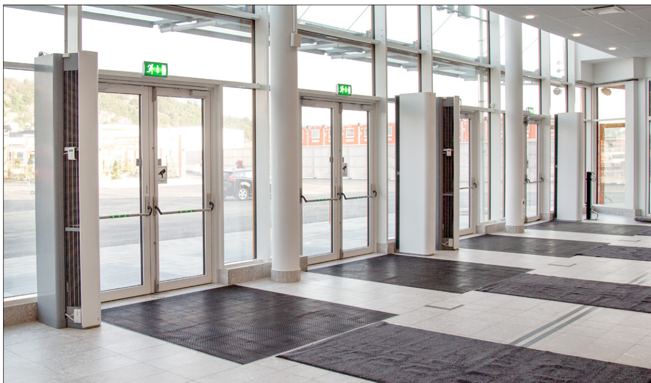
Vertikalt monterad Pamir 3500 med designpaket för att dölja rör och kablar.
