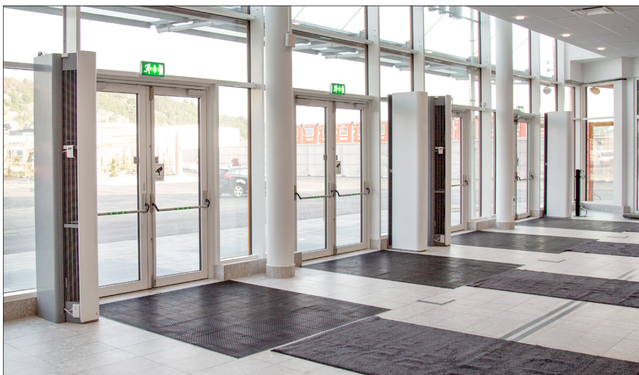
Verticaal gemonteerde Pamir 3500 met een designset voor het wegwerken van leidingen en kabels.
