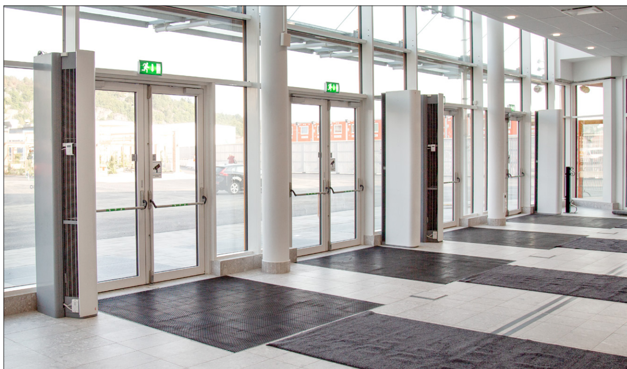
Pamir 3500 monté à la verticale avec kit finition pour masquer les tubes et les câbles.
