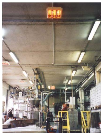
L'IRCFC peut être monté au mur ou au plafond et convient aux bâtiments utilisés de façon irrégulière (cette aire de départ des pistes de kart d'Argenteuil, par exemple).
