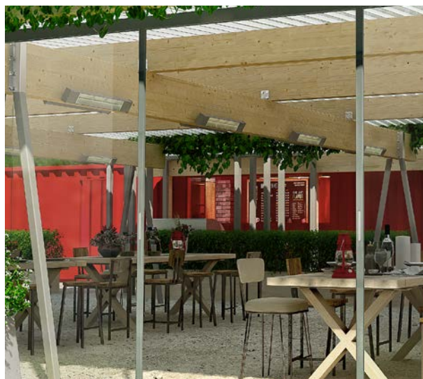
Promienniki są doskonałym rozwiązaniem na zewnątrz, ponieważ ogrzewają bezpośrednio ludzi i przedmioty, a nie otaczające ich powietrze.
