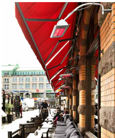
Med et forlengerfeste kan varmeren plasseres lavere enn monteringspunktet.
